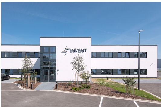
Der neue Standort der INVENT GmbH in Braunschweig ist auf weiteres Wachstum des Unternehmens ausgelegt.
